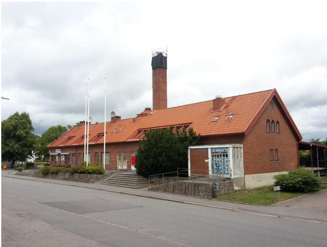
Figur 19. Foto: Den befintliga butikslängan och före detta panncentralen
